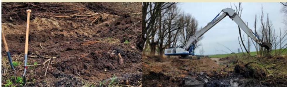
▲ Figuur 5. Eind februari. Bestaande hollen zijn voorzichtig met een schop uitgegraven zodat de kans op het verwonden van een eventueel aanwezige bever zo klein mogelijk is. Vervolgens zijn hollen wederom met stokken half afgesloten om te bepalen of er nog graafactiviteit van bevers plaatsvindt.
