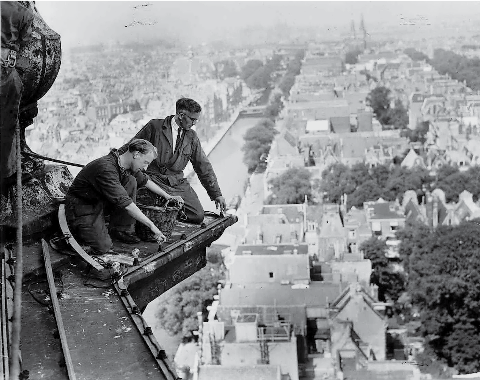
Twee mannen installeren feestverlichting op de Amsterdamse Westertoren.
